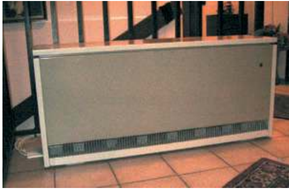
Wärmespeichergerät
